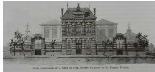
CITY SCHOOL N° 4 1884 / ARCHITECT EUGENE FRISCHE EDWARD VAN EVEN / LOUVAIN DANS LE PASSE ET LE PRESENT / LEUVEN / 1995
